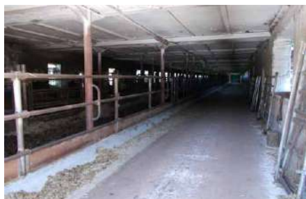
Nově zrekonstruovaná stáj v HO
